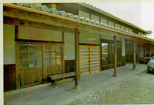
改修後の長屋門
