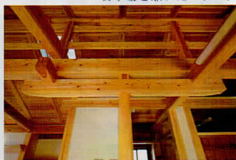
梁組みが室内のアクセント
