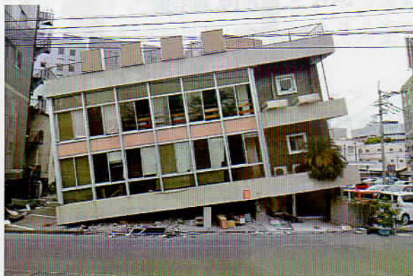
1階のピロティ・店舗部分が崩壊したコンクリート造のビル（熊本市内）
