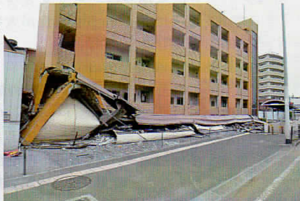
1階のピロティ・店舗部分が崩壊したコンクリート造のビル（熊本市内）
