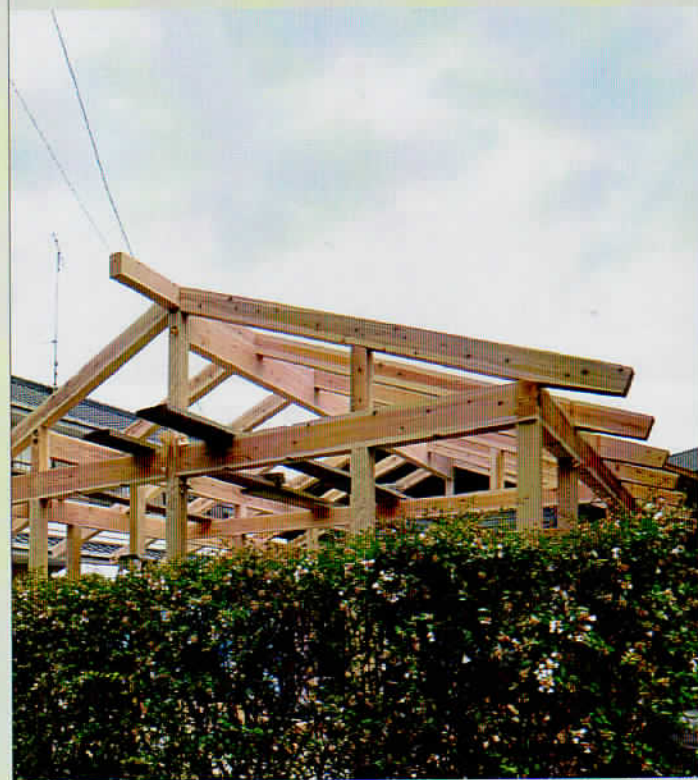
増築部の棟上げ
